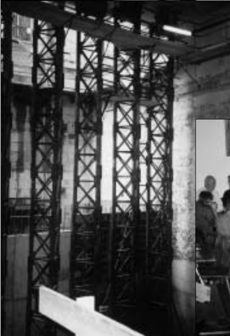
Provisorische Pfähle zur Abstützung des Gebäudes
