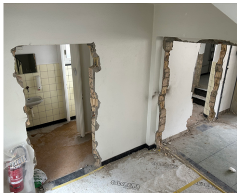
WC-Anlagen im EG und Eingang zum Schulungsraum
